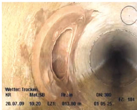
Bild 7: Erfolgreiche Sanierung mit Hächler EL 300/600
