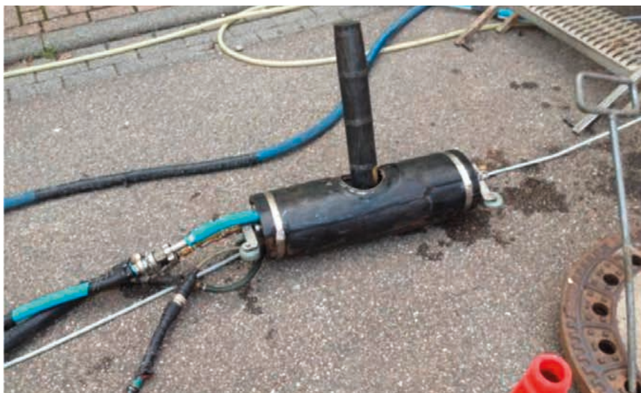
Bild 1: Injektion mit Mörtel (Strobel-Packer)
