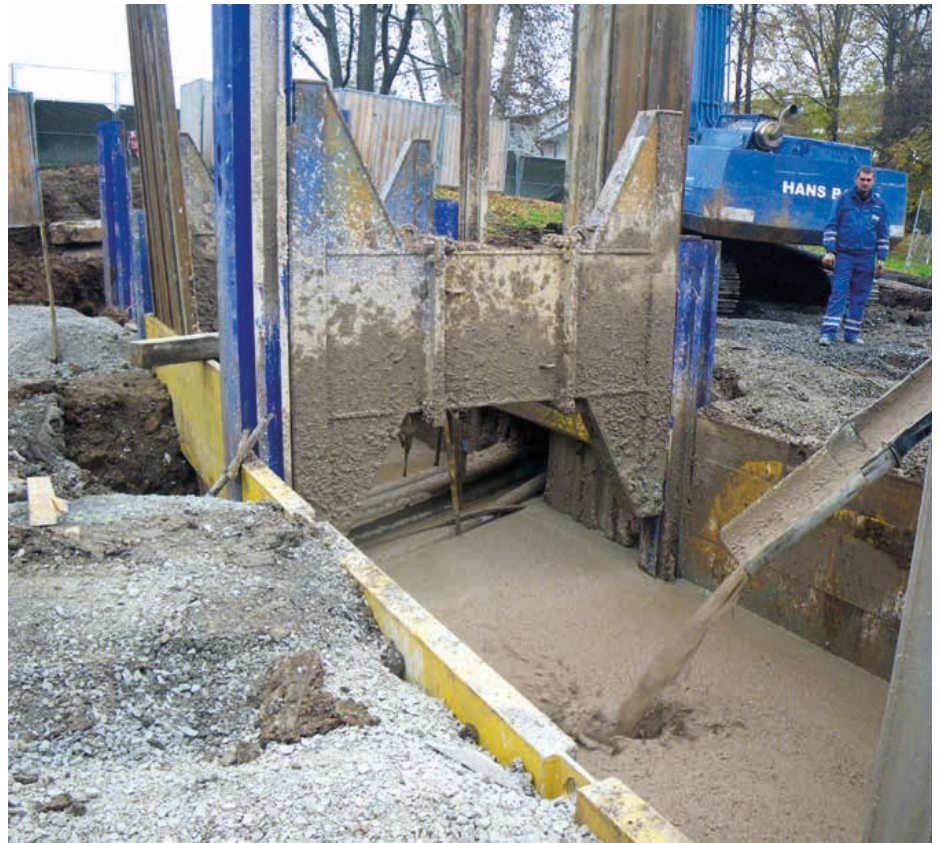
Einbau Flüssigboden in Rohrgraben für DN 2200 im Schlossgarten Stuttgart. | Fotos: Vogel Ingenieure
