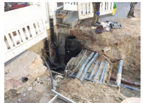
Herausforderung Bauen im Bestand in der Ratskeller Straße in Achern. Wäre hier eine fachgerechte Herstellung Rohrgrabenverfüllung ohne Flüssigboden möglich?
