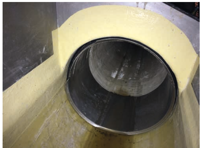
Die Abdichtung des Liners zu den GFK-Formteilen erfolgte mit Linerendmanschetten. | Fotos: Vogel Ingenieure
