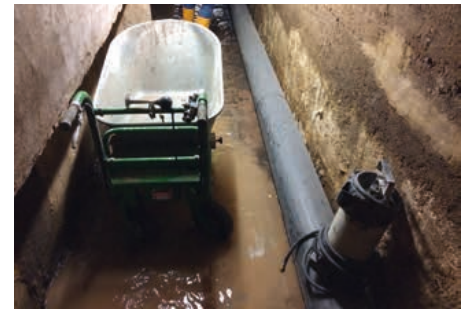
Wenig Platz und lange Wege: Für den Materialtransport wurde auch eine akkubetriebene Schubkarre eingesetzt. Rechts unten liegt das Druckrohr für die Abwasserüberleitung.
