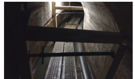
Um die Kräfte bei Einzug des Stützgewebes abzufangen, wurde der Sammler an den kritischen Stellen gegen das Gewölbe ausgesteift.
