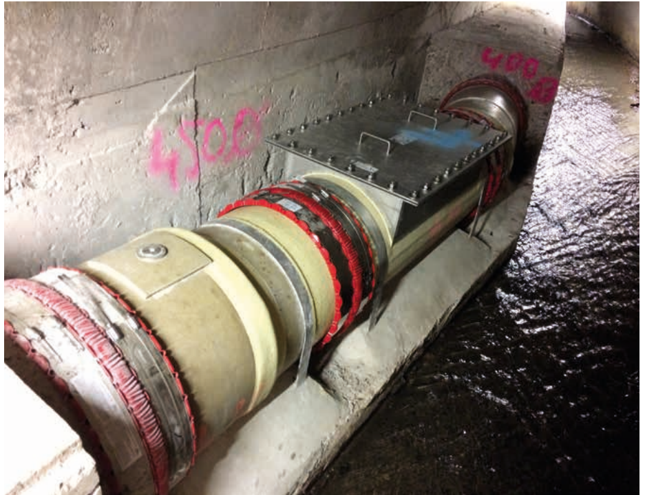
Auf der Sanierungsstrecke waren vor dem Linereinbau vier maßgefertigte GFK-Formteile einzubauen. Zu erkennen ist auch der Verpressstutzen für das später erfolgte Verdämmen des Liners.
