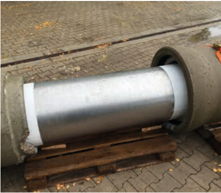
Bei dem Testeinbau stellte sich heraus, dass die Dehnung des Stützschlauches größer war, als in den Vorversuchen ermittelt.
