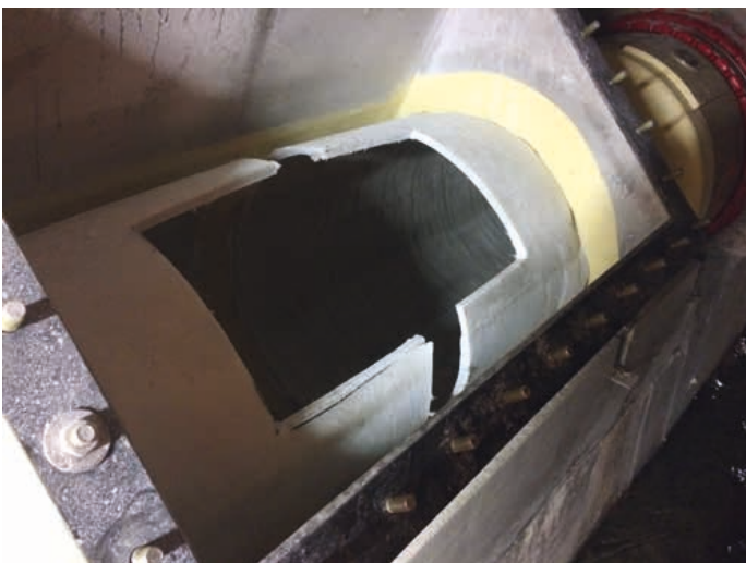
Um die Spannungen im Liner abzubauen, wurde der Liner im Abstand von etwa 90 Metern getrennt.
