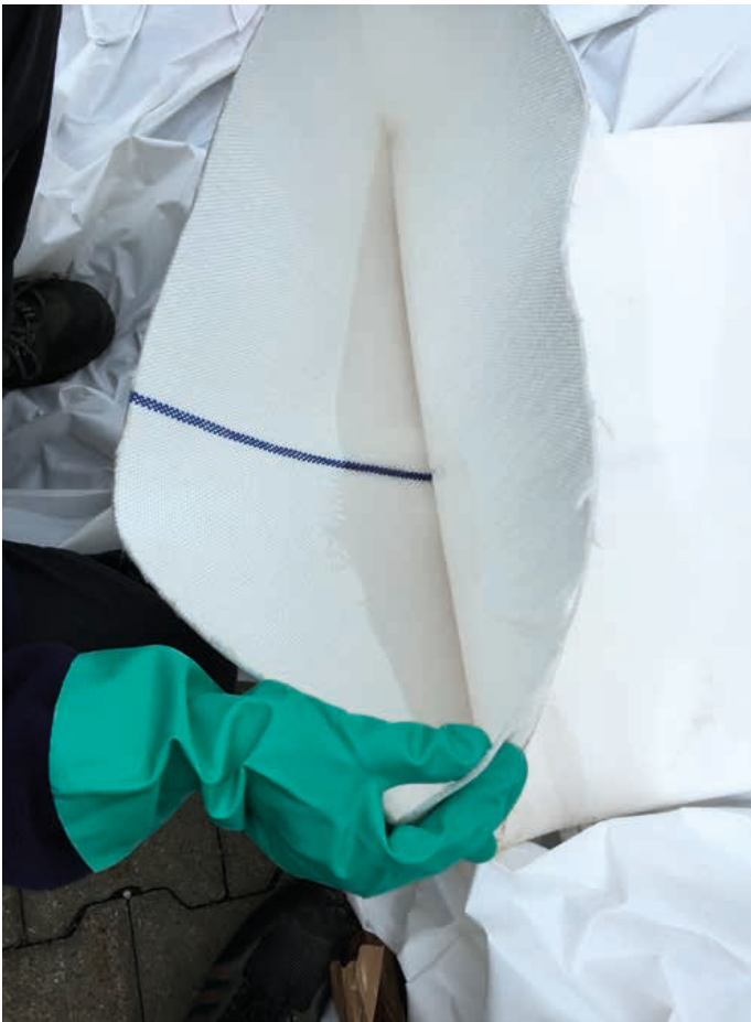
Das ausgewählte Stützgewebe des Herstellers Norditube kommt normalerweise bei der Sanierung von Druckrohrleitungen zum Einsatz.
