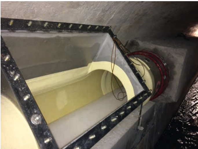
Der eingezogene Stützschlauch.
