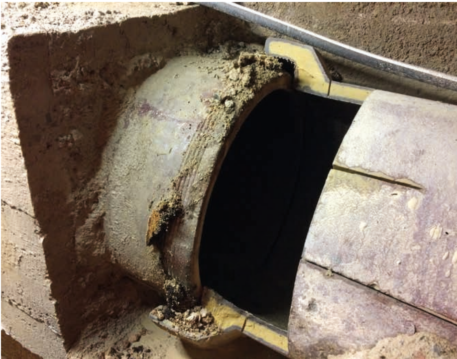
Beim Abbruch der Betonummantelung und dem Trennen der Steinzeugrohre war große Sorgfalt erforderlich.
